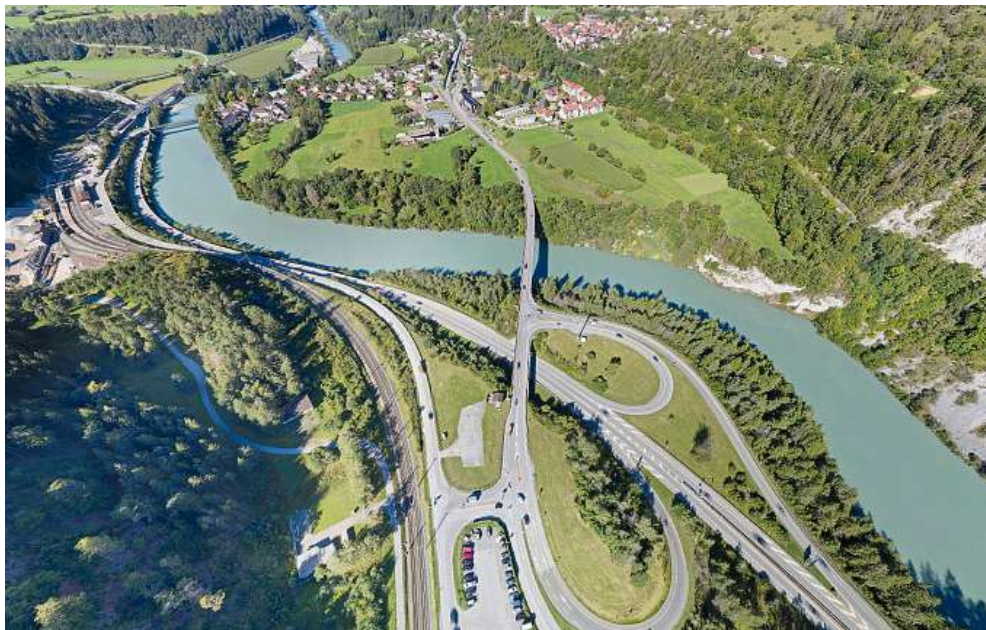
Domat/Ems soll einen Anschluss an die Wasserversorgung der Gemeinde Tamins bekommen – die Leitung wird von Tamins der Rheinbrücke entlang bis zum Parkplatz auf Emser Boden führen. Foto zVg
