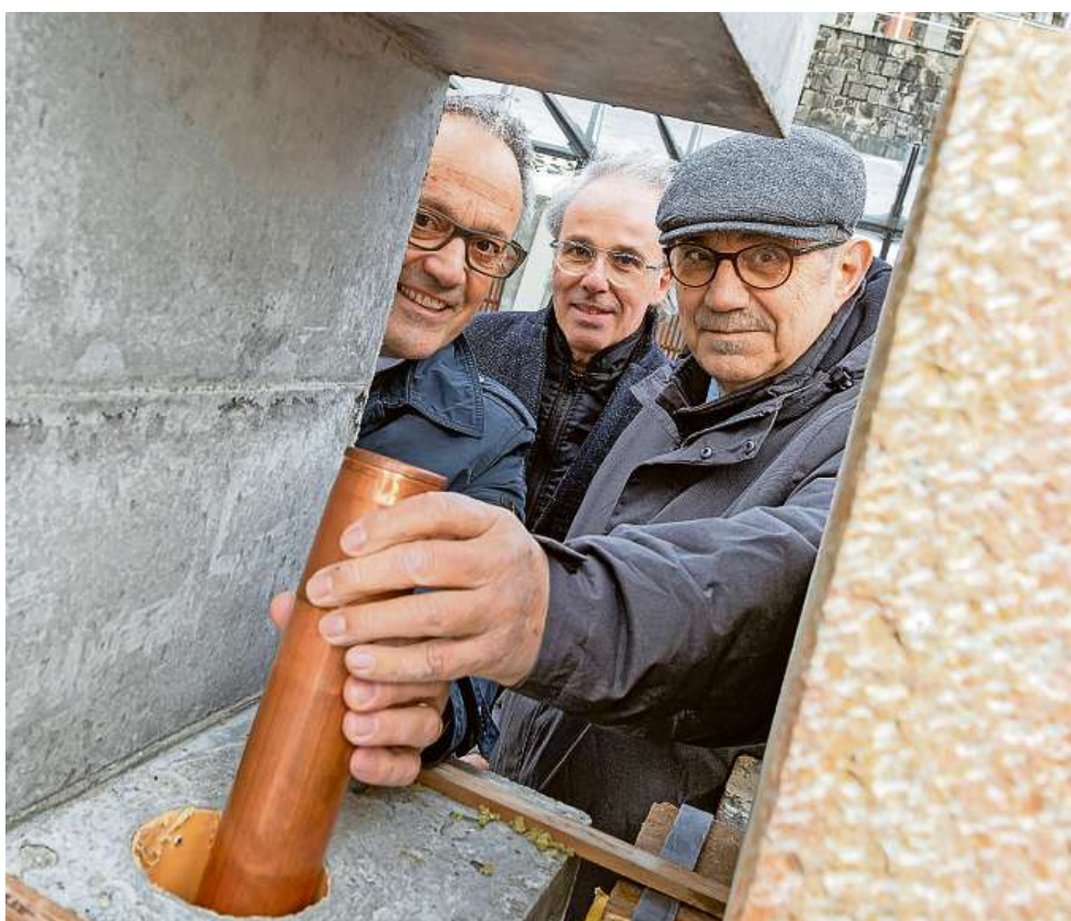
Grundsteinlegung durch den Gemeindepräsidenten Erich Kohler (von links), den Leiter Bauamt Ernst Schild und dem Departementsvorsteher Bauwesen und Anlagen Armin Tanner. Pressebild
