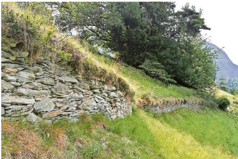
Um Lebensräume zu erhalten, sollen die Trockenmauern am historischen Verkehrsweg im ehemaligen Weinbaugelände Vegna instand gesetzt werden.
