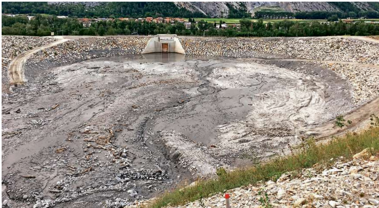
Hauptbauwerk: Das Rückhaltebecken oberhalb der Kantonsstrasse fasst rund 170 000 Kubikmeter Geschiebematerial. Bild Hans Peter Putzi
